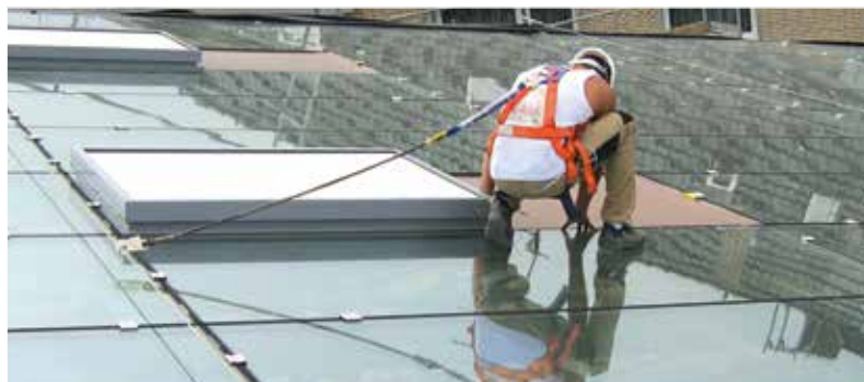
Personen-Seilsicherungssysteme auf Dächern
